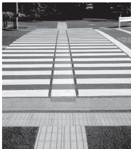
【写真8.1】 エスコートゾーンの設置例
